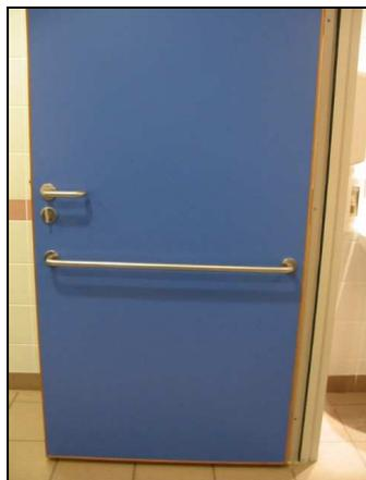
*La clenche est située trop haut. La lisse doit être à même hauteur que la clenche et sa longueur doit être réduite.*
